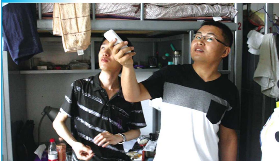
2014年6月1日上午9:00,随着空调打孔冲击钻的轰鸣,我校学生公寓空调入户安装工程正式启动。经过近2个小时的努力,研究生1号公寓1422房间的空调安装完毕。当盛夏、重志超两位同学接过空调遥控器并启动空调,凉风从空调里欢快地吹出时,结束了我校学生公寓无空调的历史。(文/申建梅 图/霍书博)
