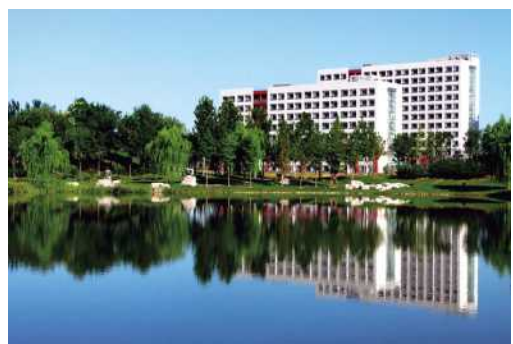
(图为北京理工大学良乡校区学生宿舍——开枫园)
