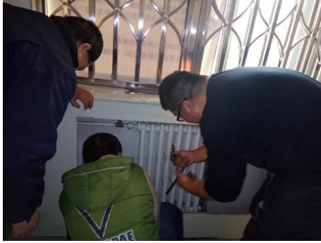
校医院暖气片漏水
