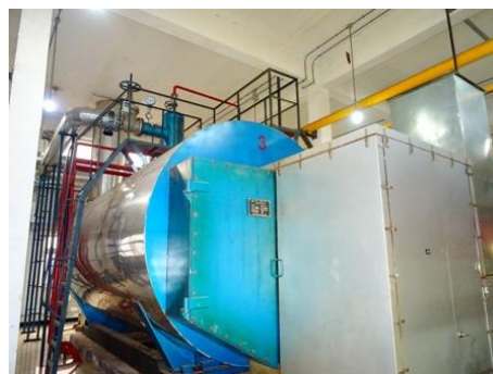
3# 炉点火试运行
