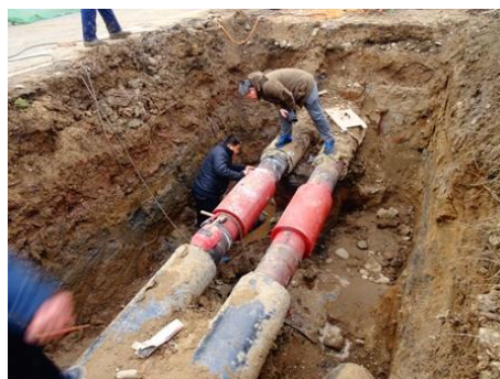
复查修复的管道
