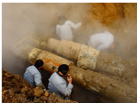
挖掘损坏的管道
