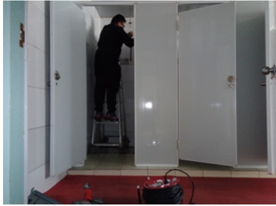
静园浴室更换阀门
