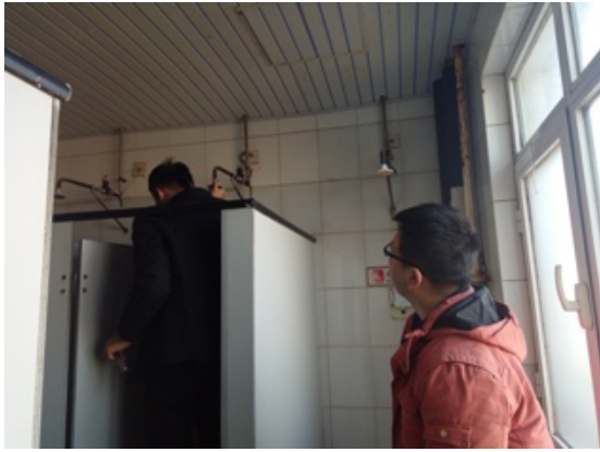
疏桐园浴室更换阀门
