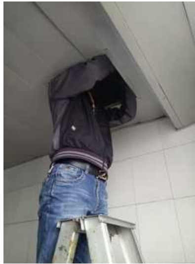
静园 B 浴室顶棚水管维修
