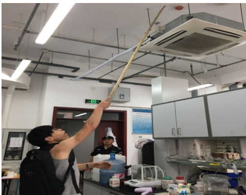
生态楼8层838房间装修后，烟感报警器被覆盖
