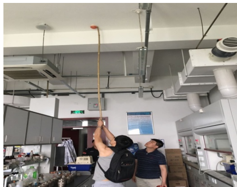
生态楼8层838房间装修后，烟感报警器被覆盖
