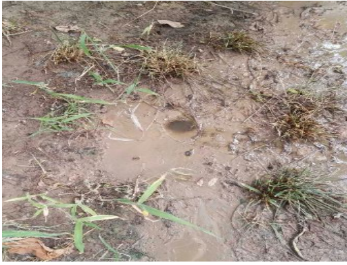
疏桐园 A 发现漏水点
