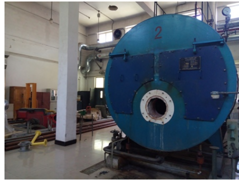
旧燃烧机拆除
