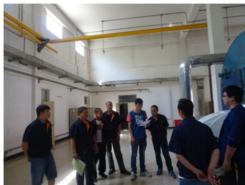
锅炉厂家对运行人员培训
