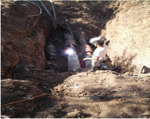
南区花园漏水修复
