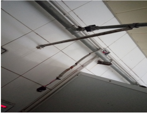
电磁阀脱落
