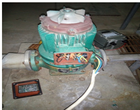
加装临时线路
