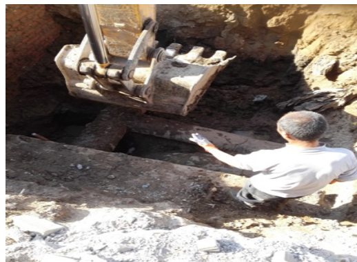
动力中心漏水修复
