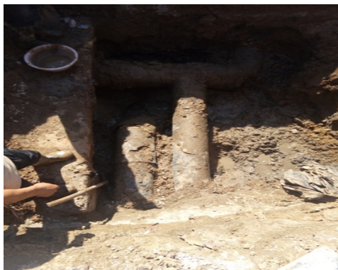
动力中心漏水点施工
