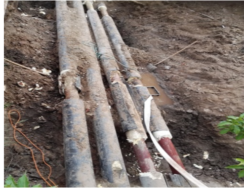
疏桐园 A 漏水点施工
