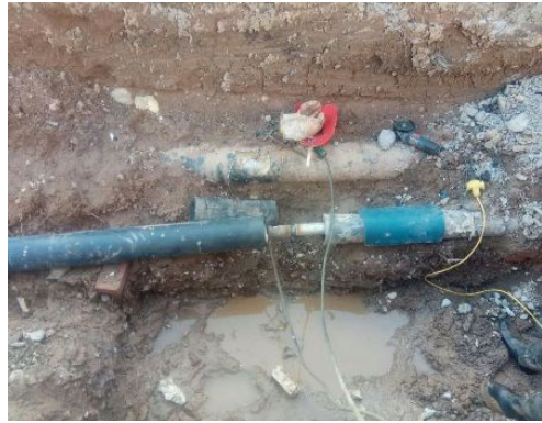
静园 D 西漏水修复
