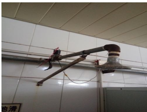
线路损坏和喷头老化
