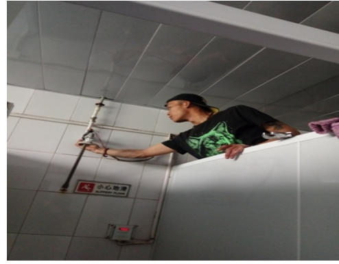
管路堵塞清洗
