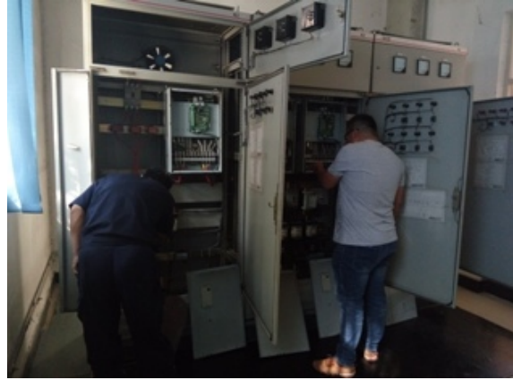
配电柜除尘检修
