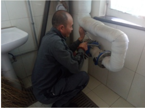
拆卸损坏阀门
