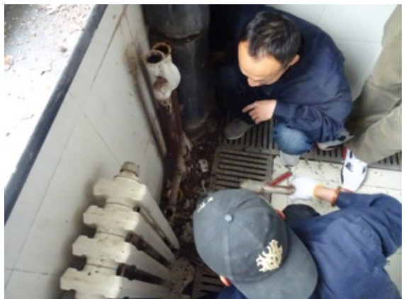
拆除腐蚀暖气管
