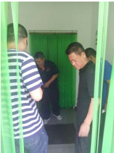
管理处检查施工
