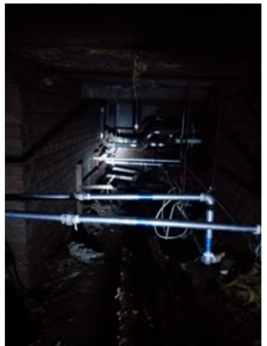
管道更新施工
