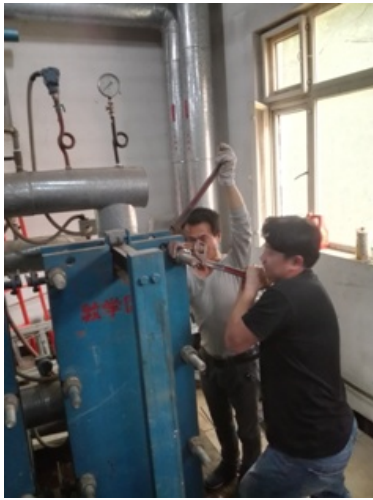
供暖换热器维修
