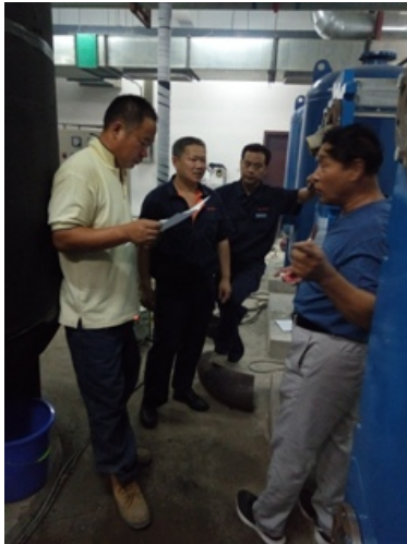
动力中心施工
