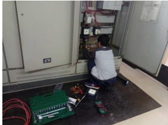
更换配电接触器
