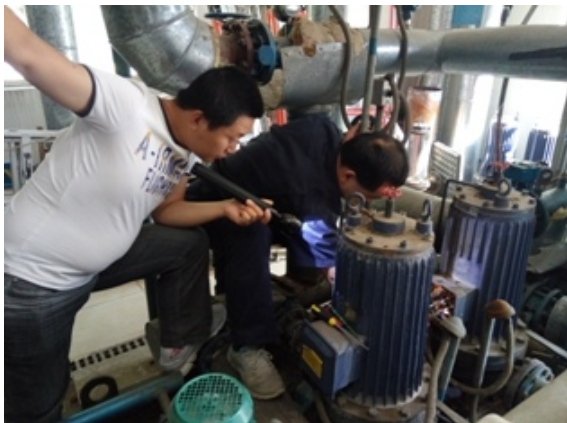
供暖循环泵检修
