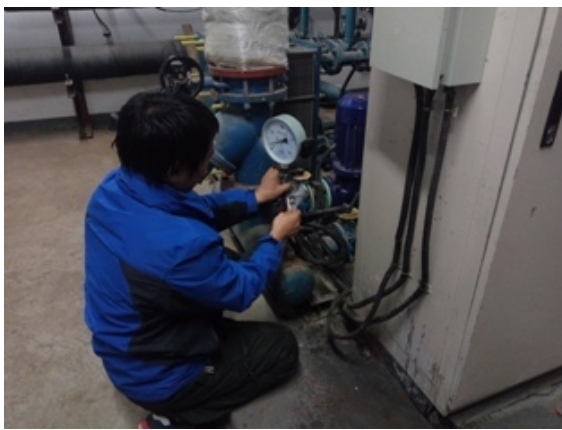
更换生态楼供暖补水压力表
