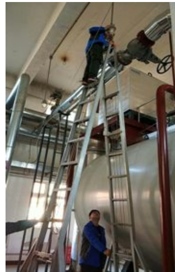
更换锅炉房灯泡
