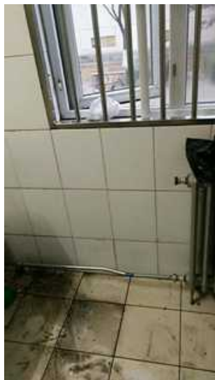
更换疏C 腐蚀暖气管
