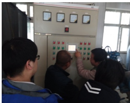
供暖补水泵、循环泵参数设定
