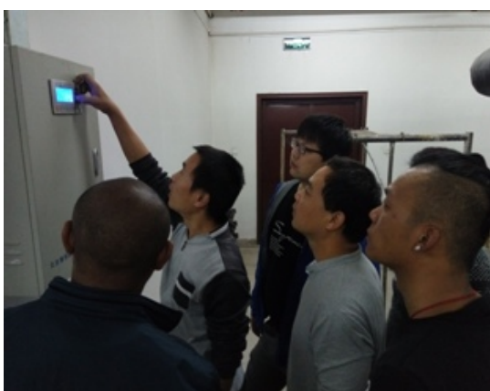
远传数据控制柜操作
