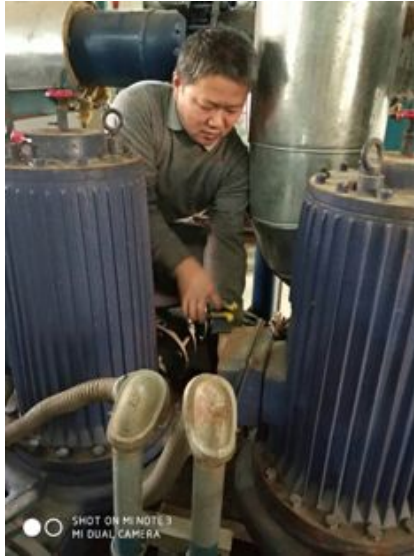
循环泵泵体检查
