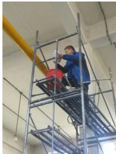
擦洗燃气管道
