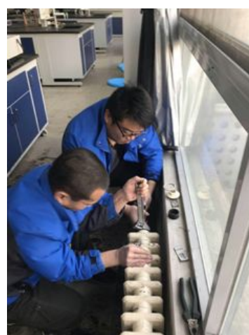
暖气现场维修
