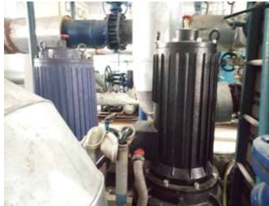
循环泵更新完成
