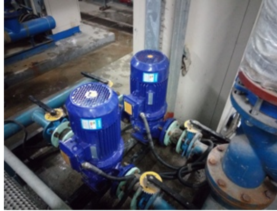
生态楼更换节能循环泵
