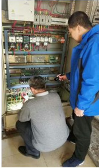
循环泵配电检修
