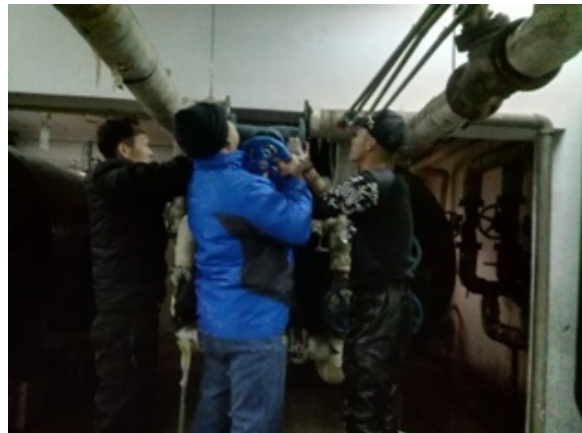
更换疏桐园 C 洗澡水总阀门
