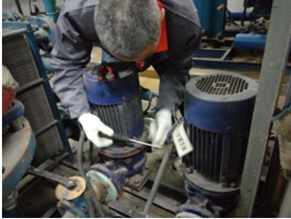
生态楼循环泵检查、修理
