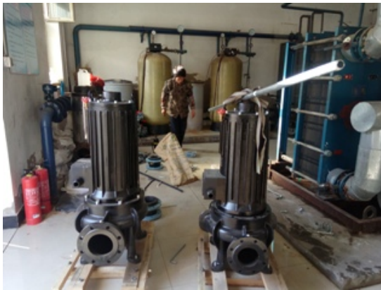
循环泵更新施工
