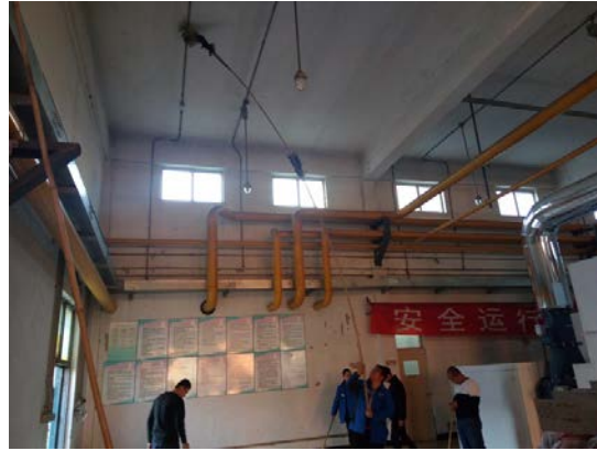
房顶除尘、除灰
