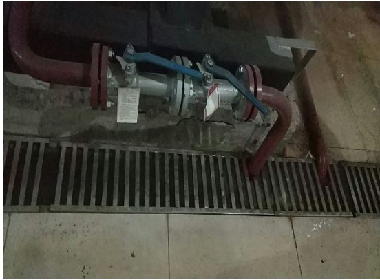
更换锅炉排污阀
