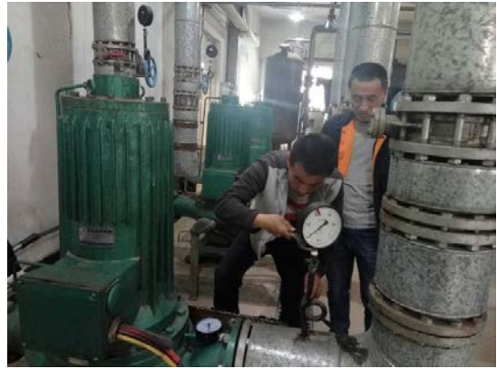
更换循环泵压力表、弯管、旋塞
