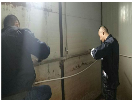
临建房洗浴更换 DN15 铜阀门
