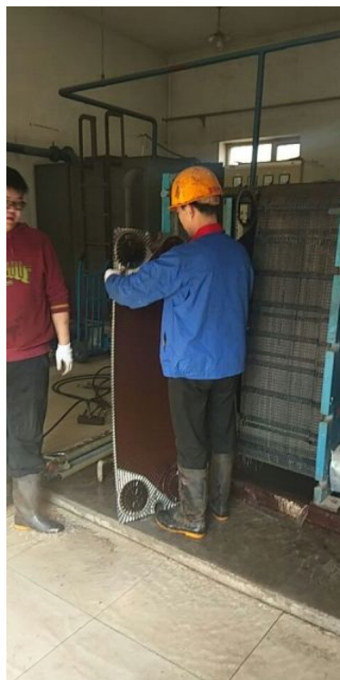
专业清洗施工
