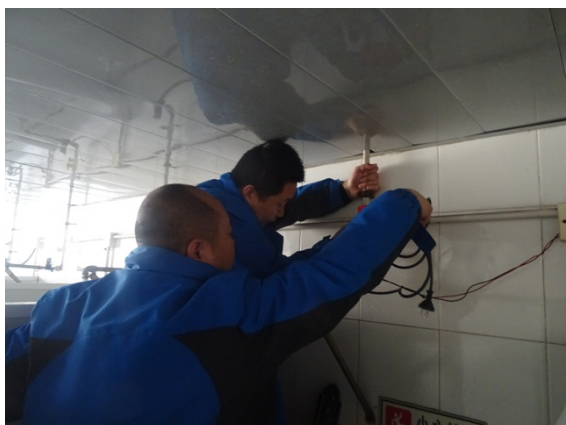
学生浴室更换热熔阀门
