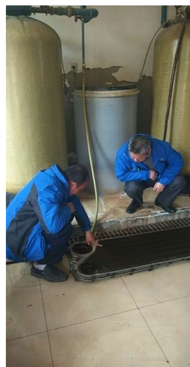
检查施工质量
