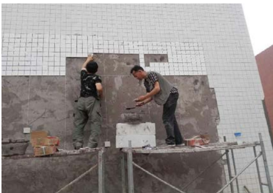
墙面贴砖恢复
