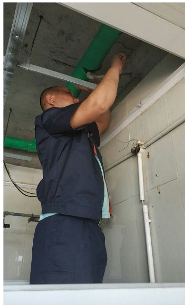
更换顶部隐藏管路
