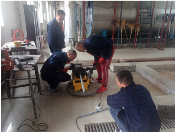
暖气安装管路改造
