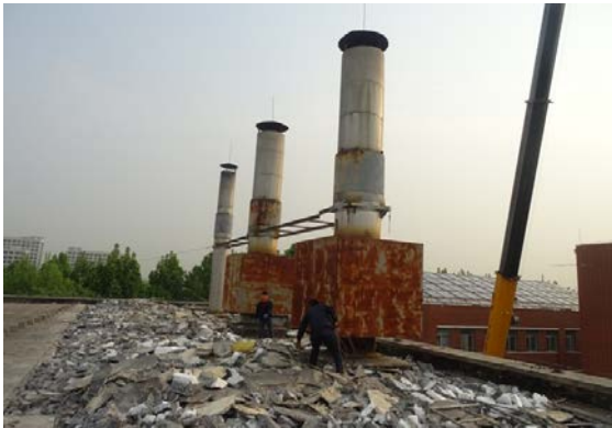
旧烟囱彻底拆除
