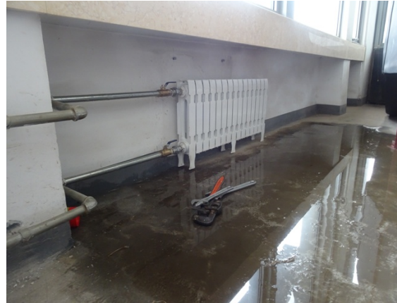
暖气片更换完成
