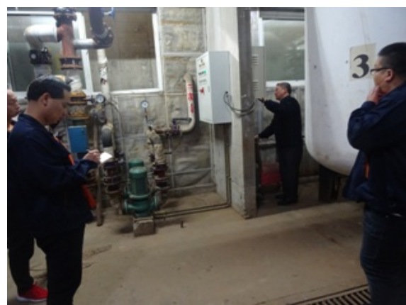
静园 D 交换站安全排查
