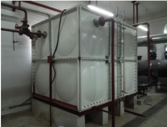
水箱除锈、防腐处理
