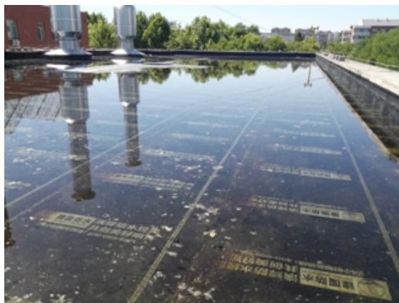
锅炉房屋顶防水工程闭水试验
