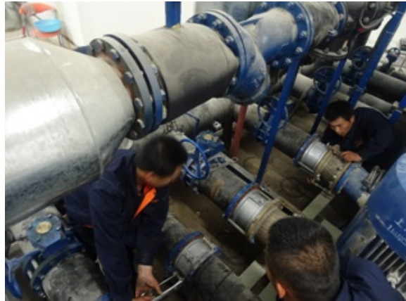
安装止回阀4台
