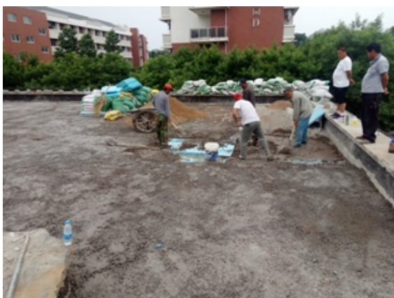
锅炉房屋顶防水工程施工
