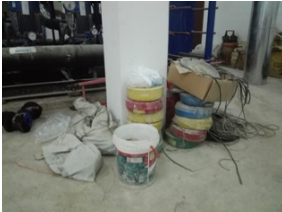
动力中心交换站材料清理
