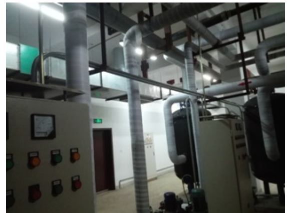
循环泵配电箱线路改造
