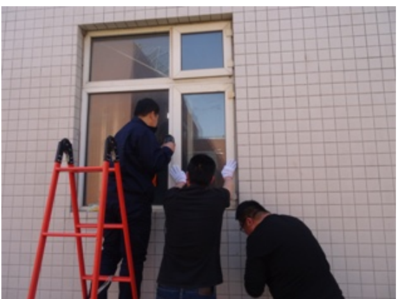
锅炉房窗户加固
