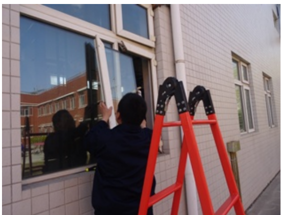
锅炉房窗户加固
