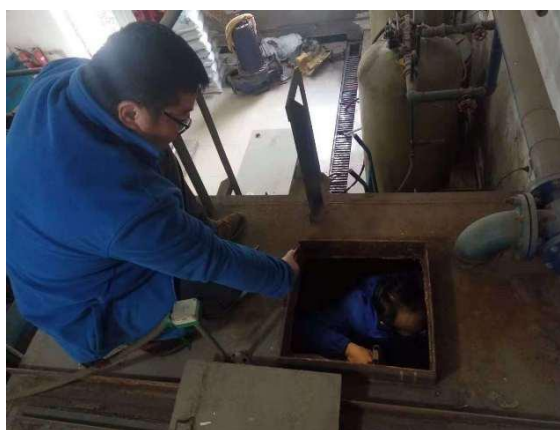
水箱水位控制维修
