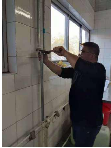
暖气管腐蚀更新
