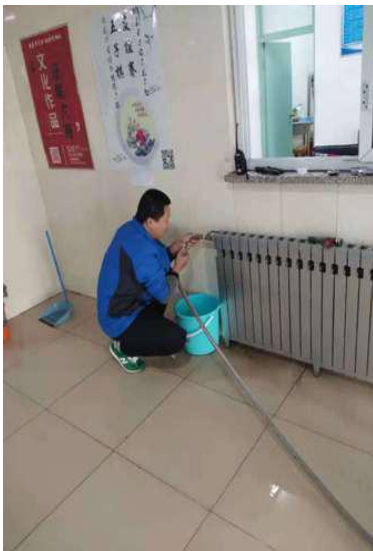
暖气异物堵塞冲洗
