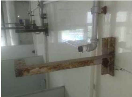
管道腐蚀漏水维修
