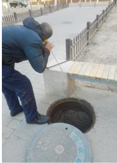
听杆探测漏点
