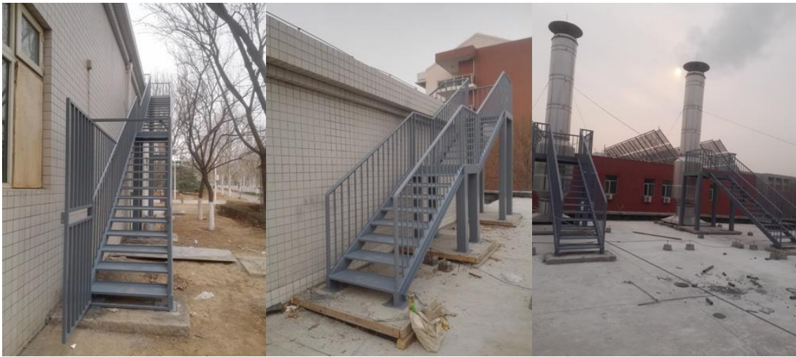
修建三段楼梯
