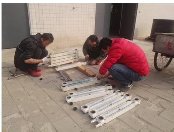
静园 D 地下室暖气漏水 拆装维修
