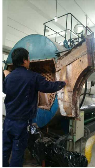
清除旧脱落隔热层
