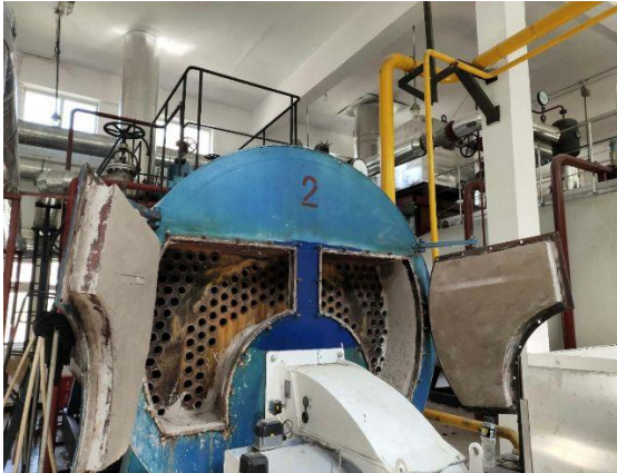
内部隔热层施工完成
