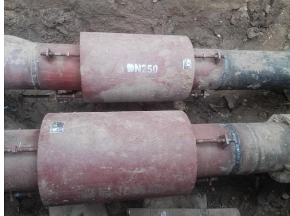
更换 DN250 补偿器 2 台
