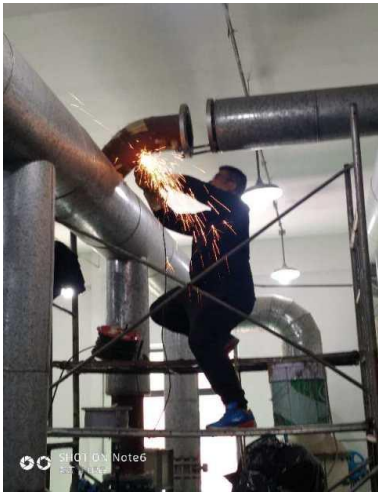
拆除止回阀及附近管道
