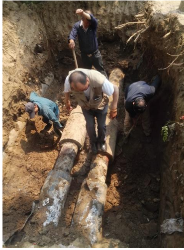
篮球场管道维修
