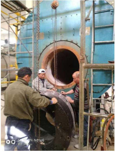
3#炉内部保温层脱落维修
