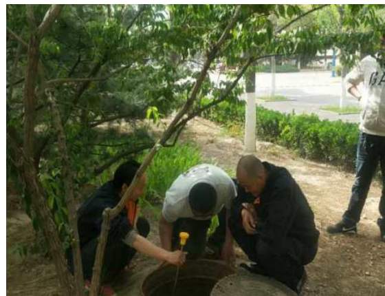
漏水点附近阀门井听、测观察
