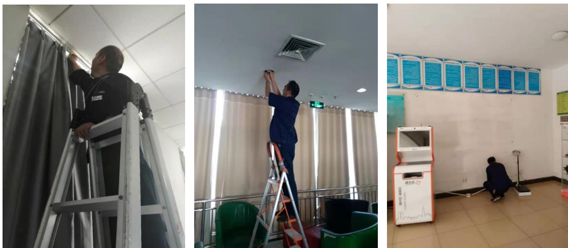
工程部维修工作
