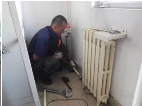
暖气管路优化施工
