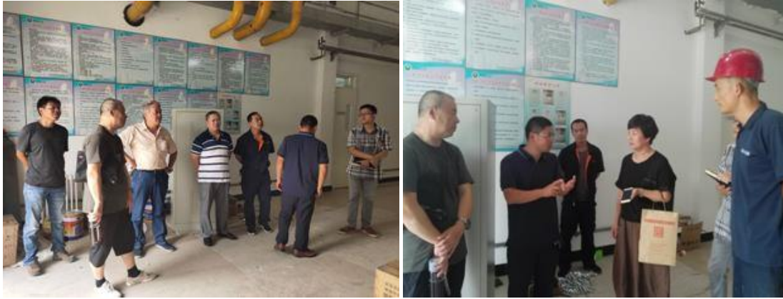
锅炉安装现场例会
