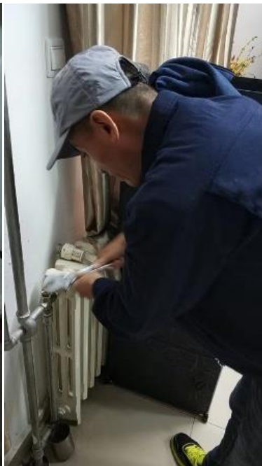
暖气漏水维修
