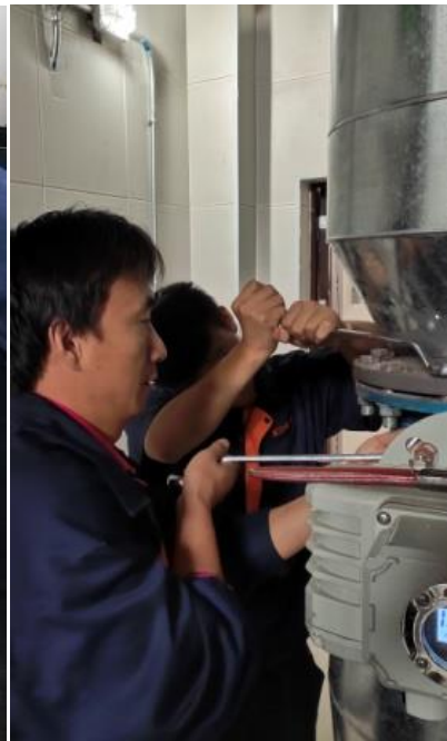
电动阀漏水维修
