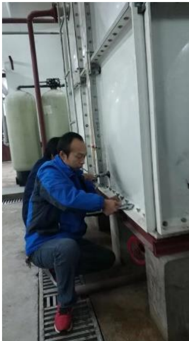
生态楼水箱维修
