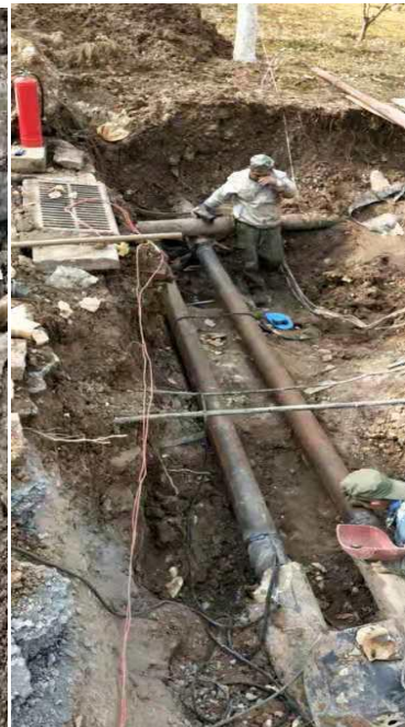
管道焊接维修完成
