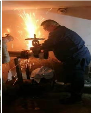
拆除腐蚀管路和阀门
