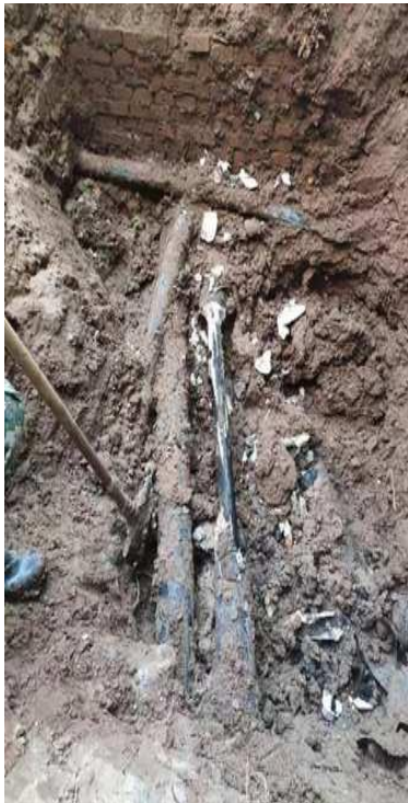
挖出学服南管道
