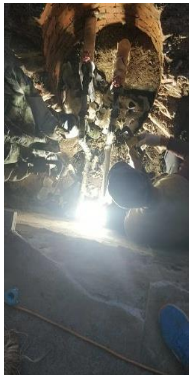
连夜抢修施工
