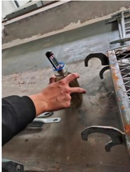
锅炉水质检测
