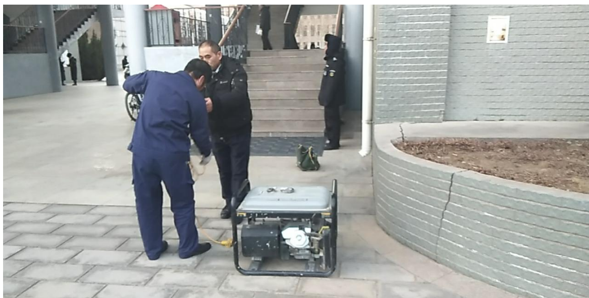
紧急供电设备调试
