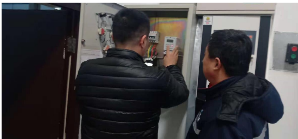
电铃设备调试
