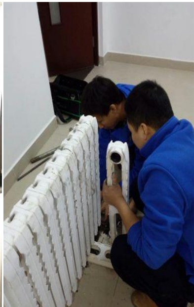
漏水暖气片拆装
