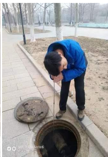
听杆排查漏水点
