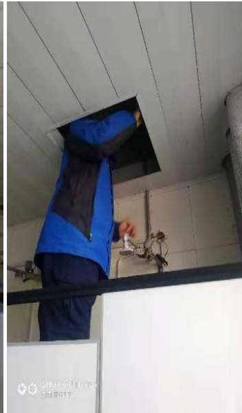
维修更换阀门
