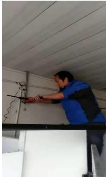
维修脱落支架
