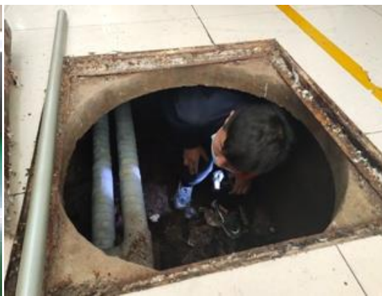
巡查供暖管沟
