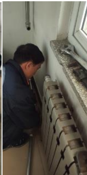
更换腐蚀暖气管
