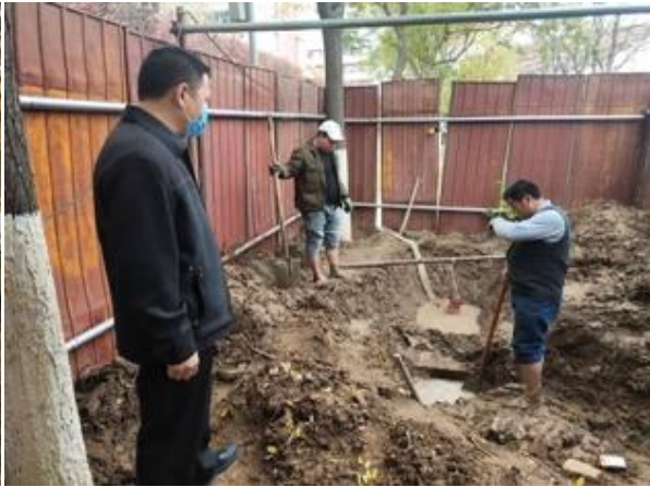
现场指导施工
