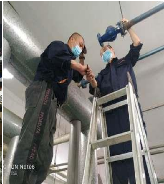
更换锅炉超压泄水电磁阀
