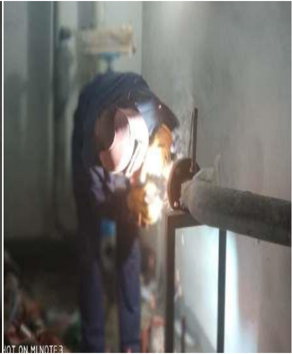
法兰管道焊接
