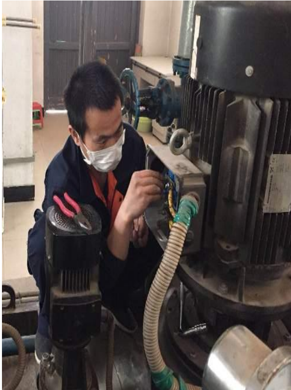
循环泵、补水泵绝缘检测
