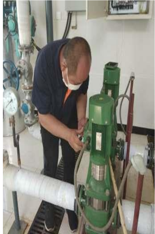
循环泵、补水泵绝缘检测
