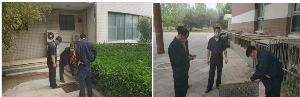
查巡供暖井积水情况
