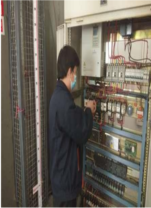
配电柜线路检修紧固接线端子
