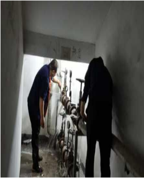
拆除旧管道及阀门
