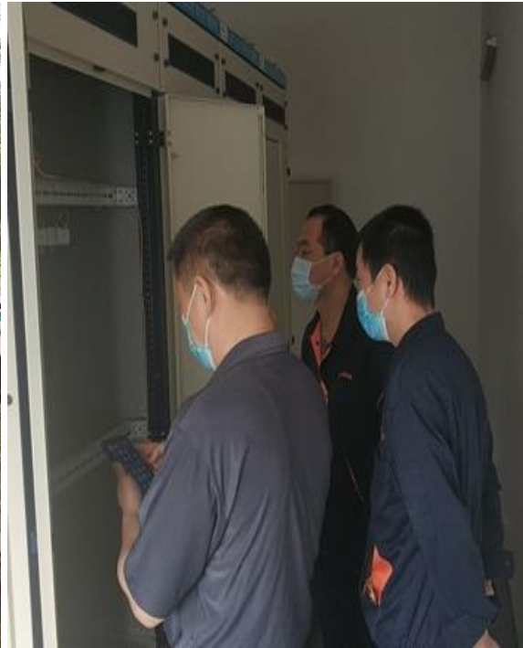
指导配电柜检修工作
