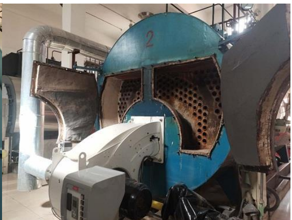
维修烟箱隔热层
