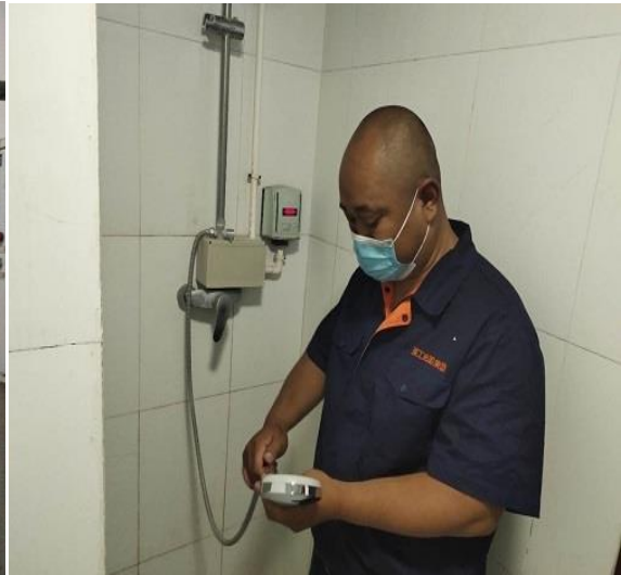
更换软管、喷头
