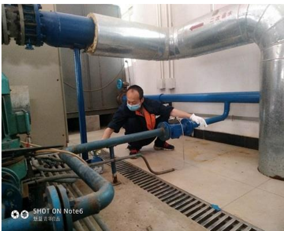
交换站管道及设备除锈、刷漆保养
