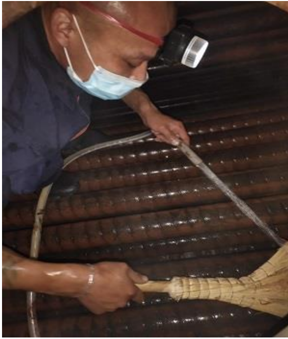
冲洗锅炉锅筒
