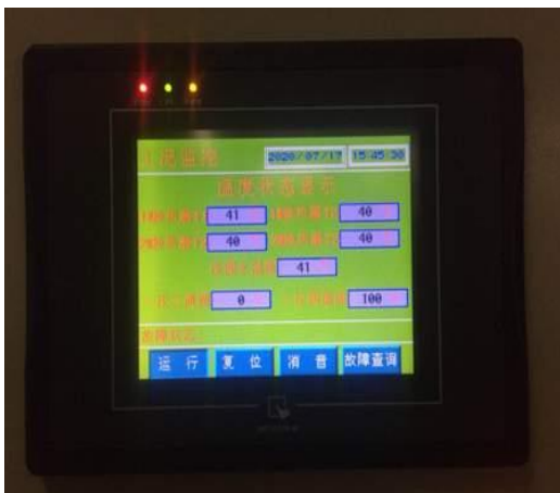
疏桐园 C 交换站
