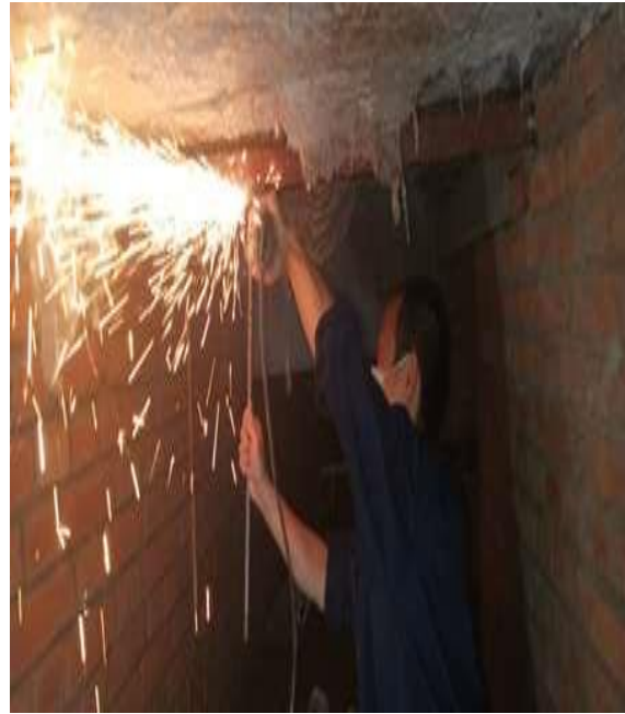
拆除地沟内暖气管
