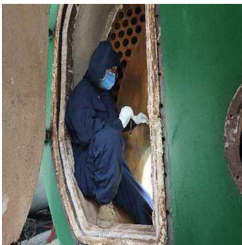
锅炉内部管板检查
