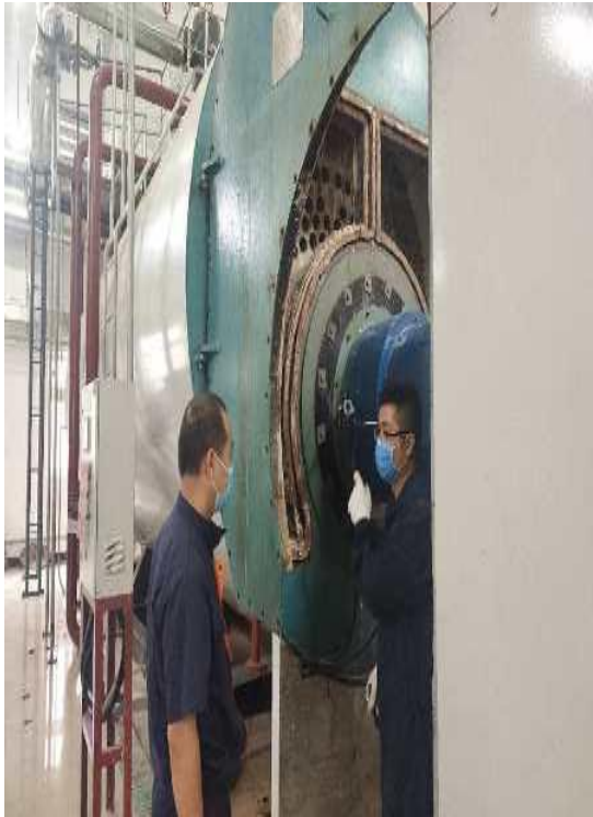
锅炉前烟箱检查
