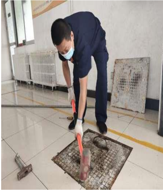
拆除室内地面检查口
