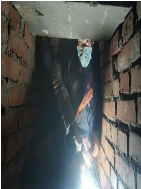
地沟内穿墙管施工
