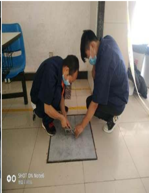
恢复室内地面检查口
