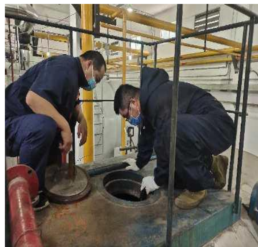
锅炉锅筒内部检测
