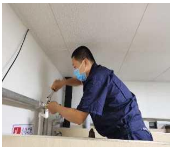
更换浴室阀门
