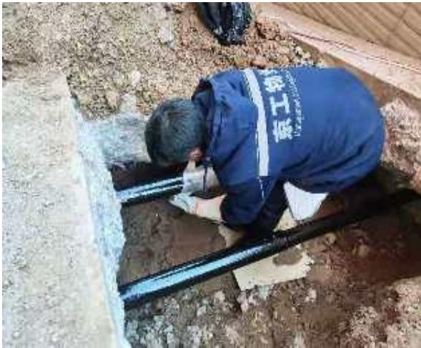
管道做防腐保温
