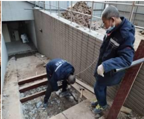
楼梯绑扎钢筋与制模
