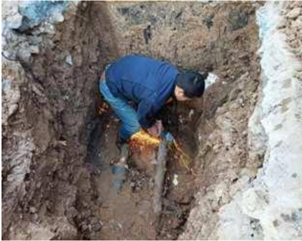
漏水管道拆除
