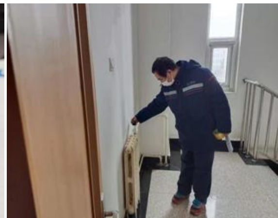
检查化学办公楼暖气
