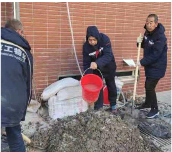
楼梯现浇混凝土
