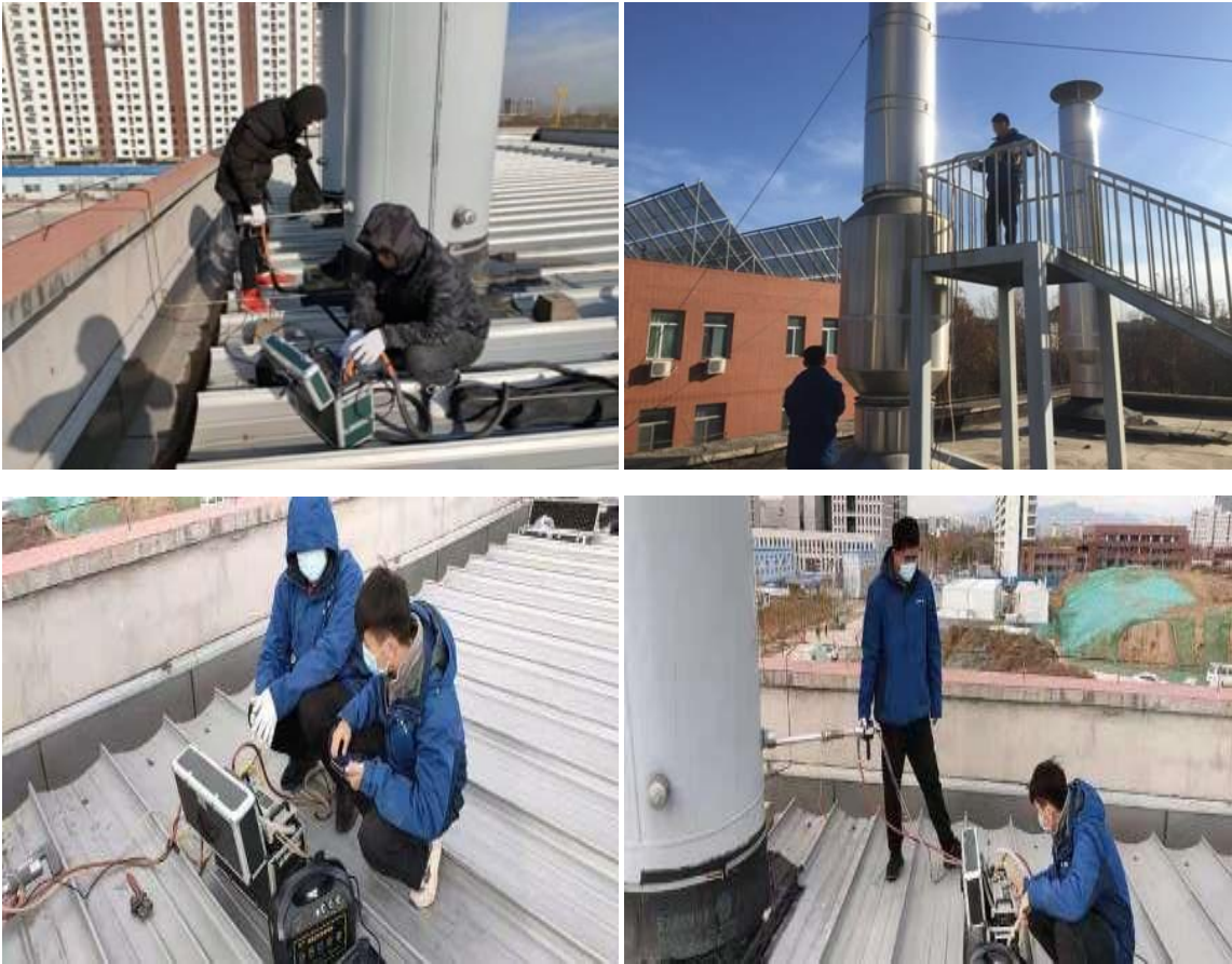
第三方检测单位人员对东、西区锅炉进行排放检测
