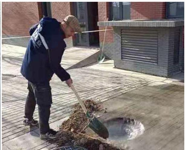
动力中心东侧热力管道漏水
