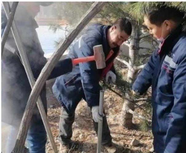
勘探确认篮球场北侧管道漏水
