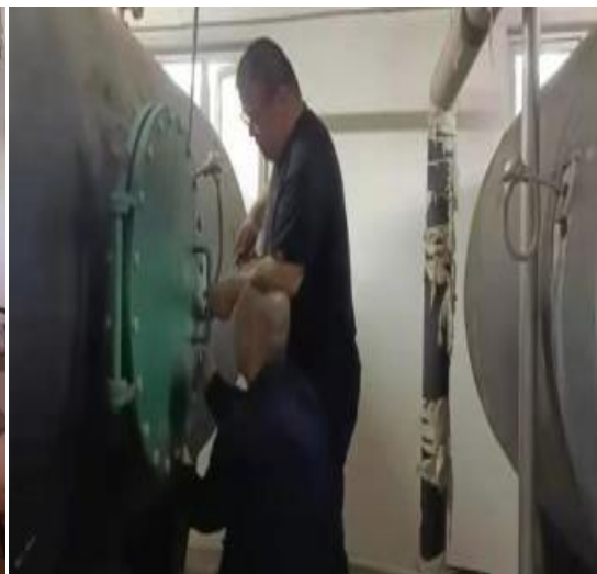
修复后安装换热罐
