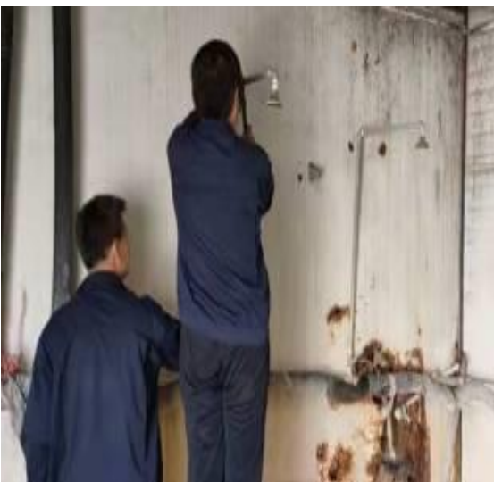
保安浴室维修
