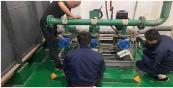
更换 2#站 3 台 DN50 单流阀
