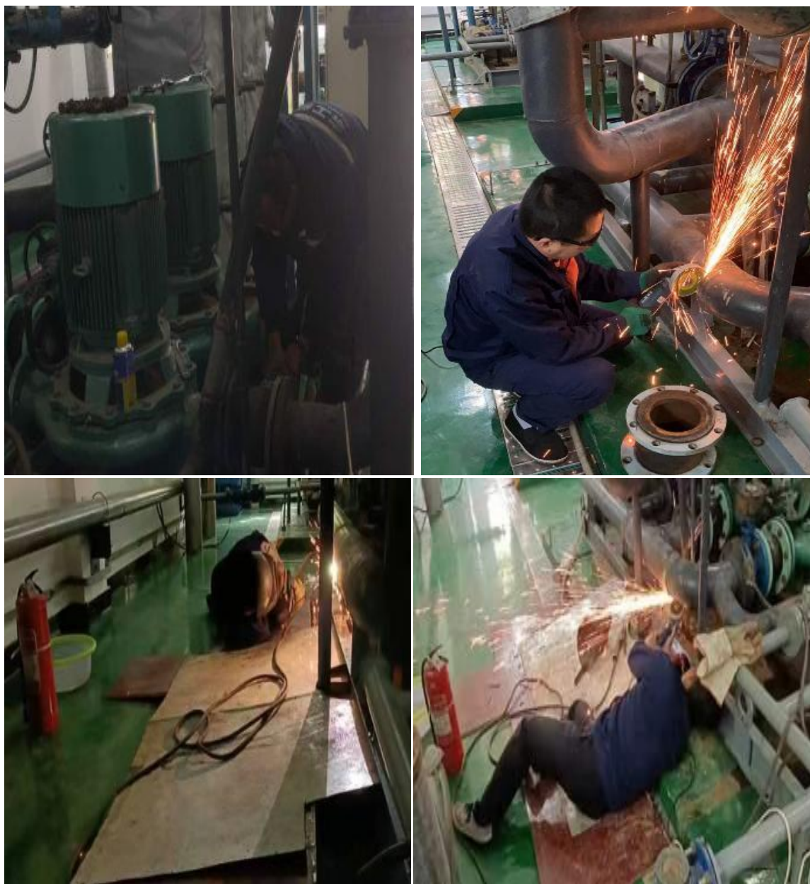
更换 2#供暖交换站生活区软连接 4 台
