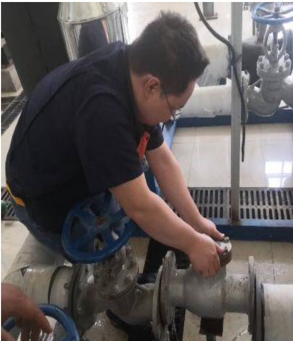
更换东区除氧泵止回阀
