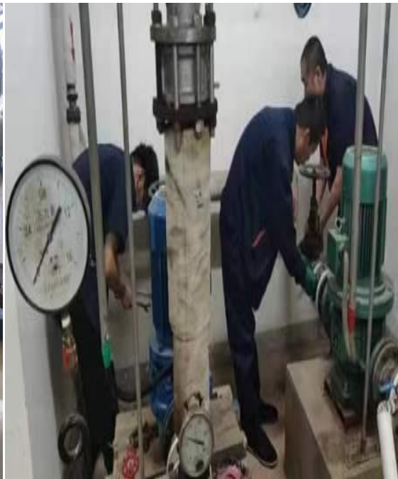
更换疏桐园洗澡交换站软连接
