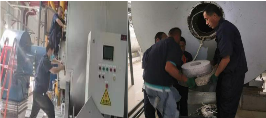
拆除东区锅炉房待检锅炉前后烟箱
