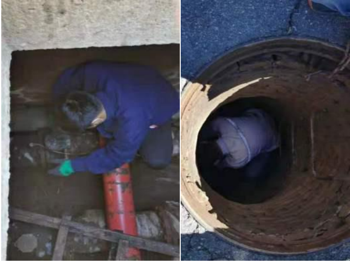
室外阀门加油保养
