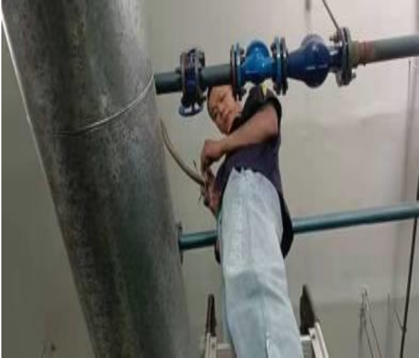
维修锅炉房一次水电动阀
