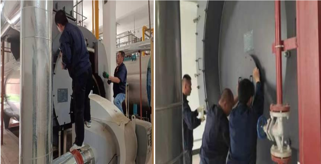
拆除西区锅炉房待检锅炉前后烟箱
