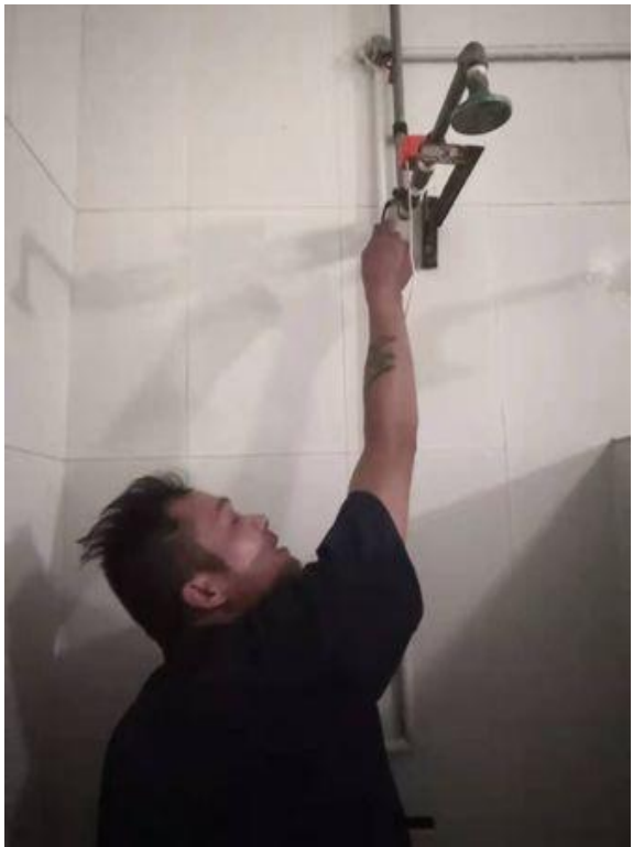
处理浴室喷头流水
