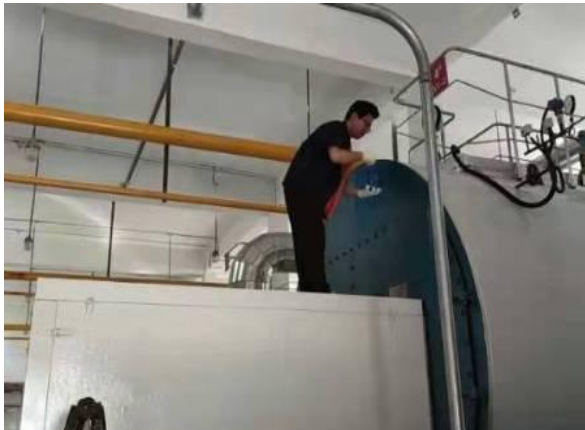
锅炉刷漆保养
