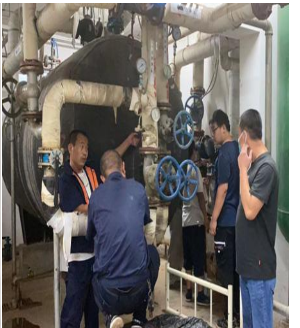
维修 3C 交换站电动阀
