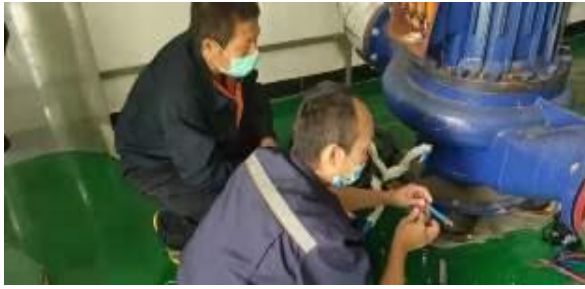
循环泵电缆新作绝缘
