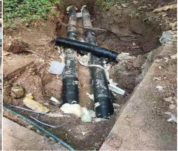
管道防腐保温
